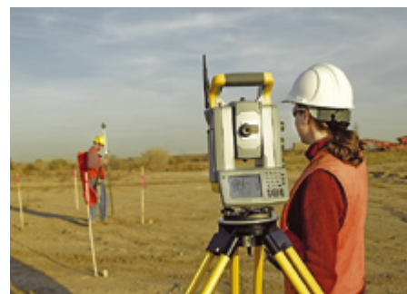
Implantation et infrastructure routière – implantation automatisée de projets simples ou complexes.
